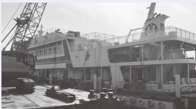
内装工事が進められているうみのこ新船です。
